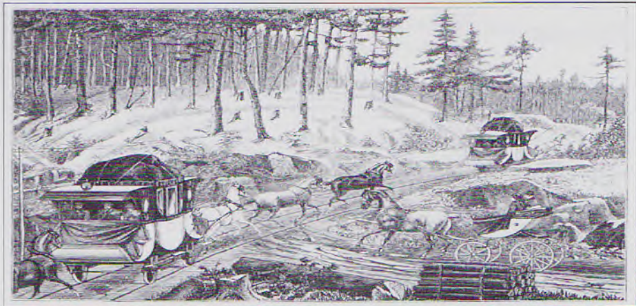
ኣብ ቡድኻይስ ሊንስ (ኣውስትሪያ) 1838 ዝነበረ ሓጺናዊ መንገዲ ኣፍራስ 3.4.3*
